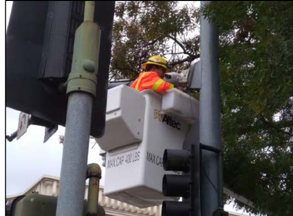
(d) Installing camera on the signal pole mast
